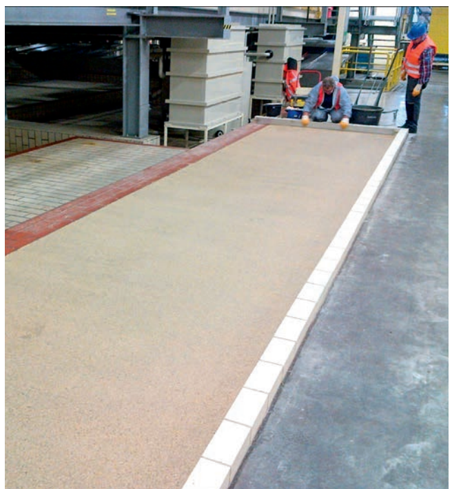
Ausführung eines Estrichbelages
