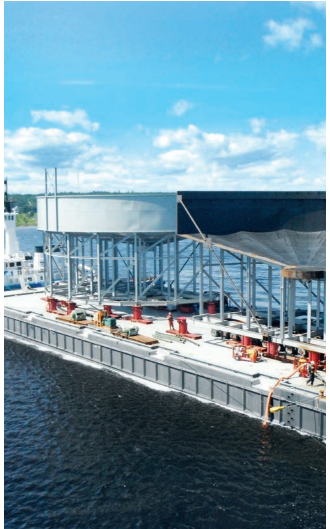
Anlieferung gummierter Behälterteile
