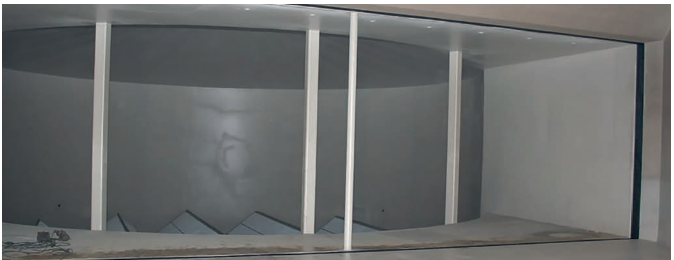
Beschichteter Reingaskanal
