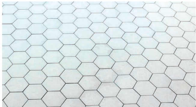
Sechseckplattenbelag in der Pharmaindustrie
