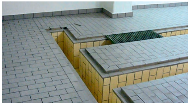
Kombinationsbelag mit Rinnenausführung
