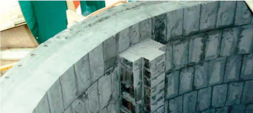
Mit Kohlenstoffsteinen und CHEMOKITT FU 1320 ausgemauerter Behälter
