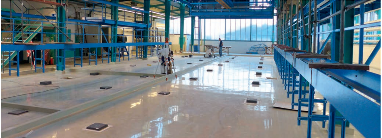
WHG Beschichtung eines Auffangraums in einem Galvanikbetrieb
