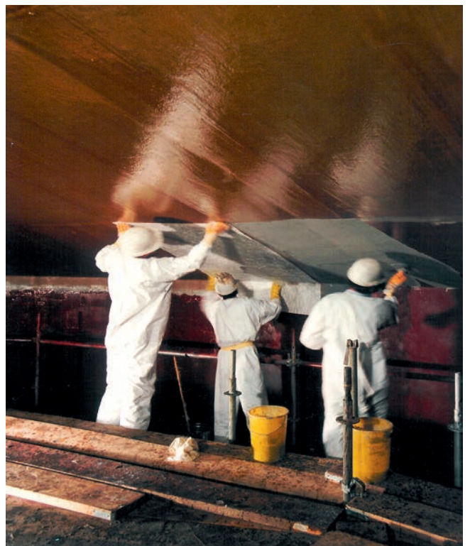
Ausführen einer Laminatbeschichtung
