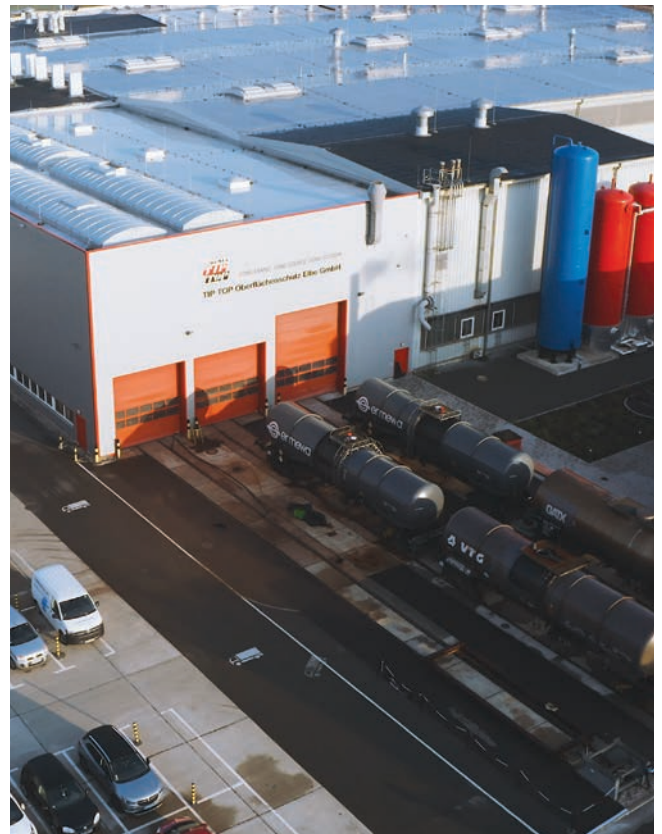
TIP TOP Oberflächenschutz Elbe GmbH in Wittenberg
