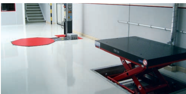
Leitfähige WHG Beschichtung in einem Produktionsraum
