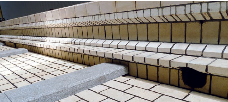
Mit keramischen Steinen und CHEMOKITT FU 1310 ausgemauerte HCl-Beize
