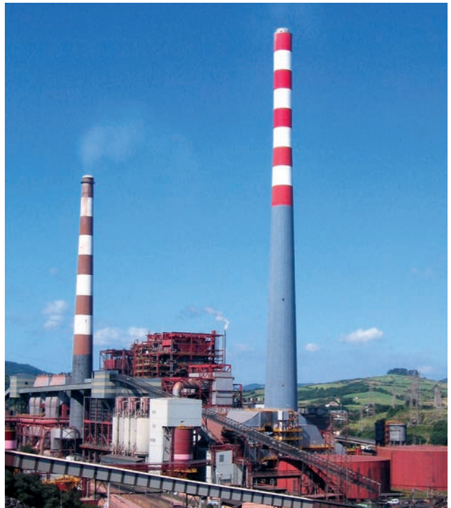
Beschichtete Kraftwerkskamine
