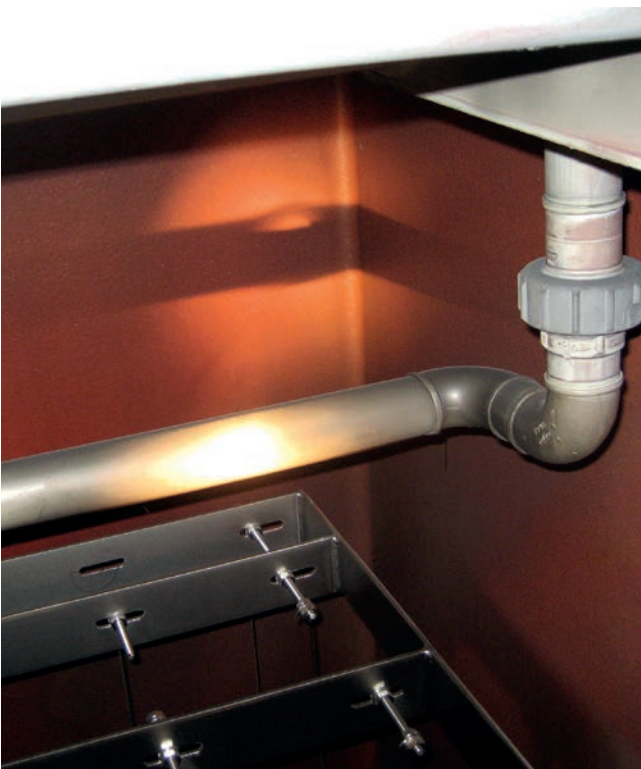
COROFLAKE Beschichtung in einem Nasselektrofilter
