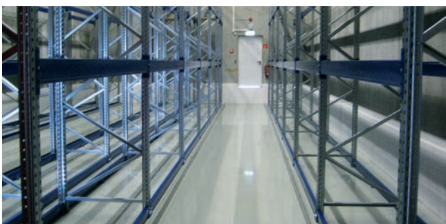
WHG Beschichtung in einem Regallager
